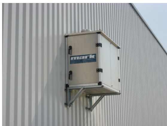
Option: brûleur à l'extérieur du bâtiment
